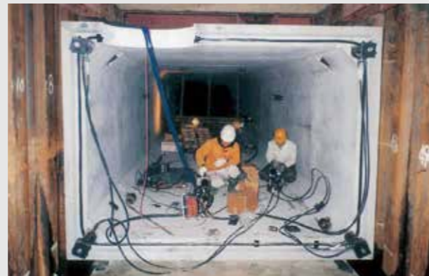
PC鋼より線による縦方向連結の施工
