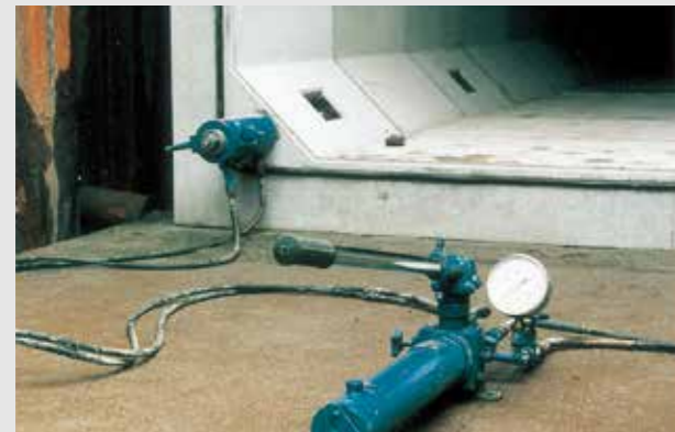
PC鋼棒による縦方向連結の施工
