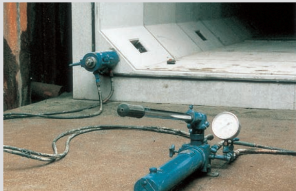
PC鋼棒による縦方向連結の施工
